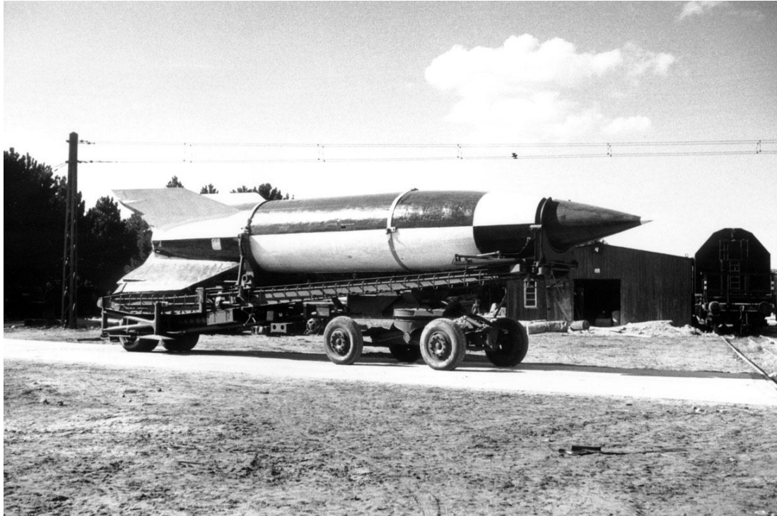
Fot. 5 Rakieta V-2 na wyrzutni mobilnej w pobliżu Cuxhaven, 1945, źródło: https://commons.wikimedia.org/wiki/File:V-2_Rocket_On_Meillerwagen.jpg , DP
