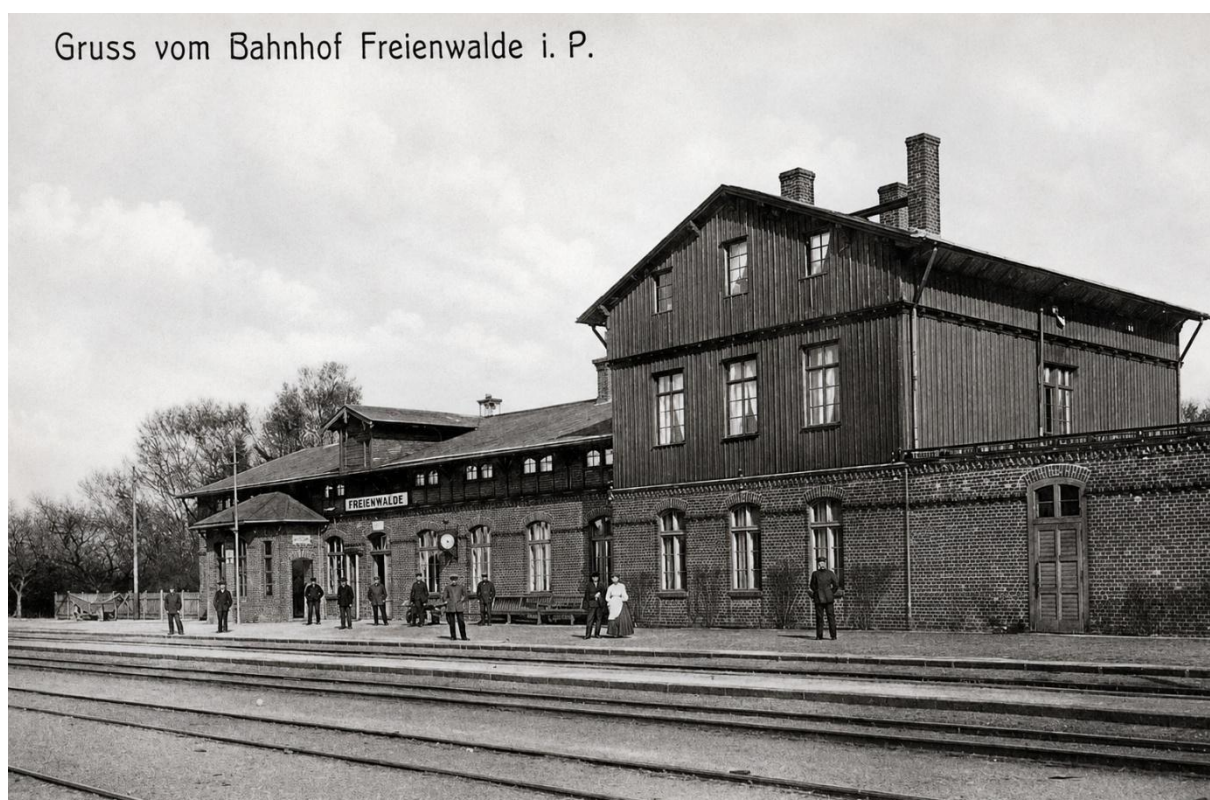
Chociwel (Freienwalde i. P.). Dworzec stacyjny o hybrydowej konstrukcji – ceglany parter i oszalowany deskami piętrowy ryzalit mieszkalny. Stan z początku XX wieku. Heimatkalender für Stargard und Kreis Saatzig 1927 (b.n.s.).
